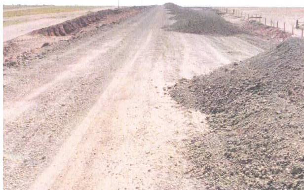
FOTO 05 – LANÇAMENTO DE MATERIAL
